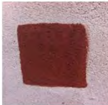
FIGURA 4 - Teste realizado com tinta de terra - 1ª Demão. Fonte: Arquivo dos autores (2015).
