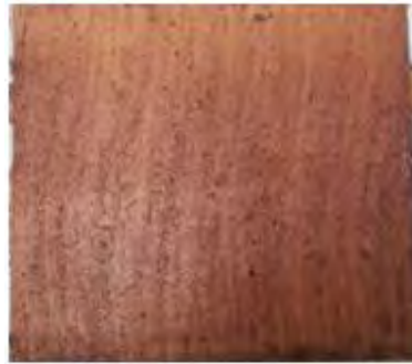
FIGURA 10 - Aplicação da tinta na placa de gesso. Fonte: Arquivo dos autores (2015).
