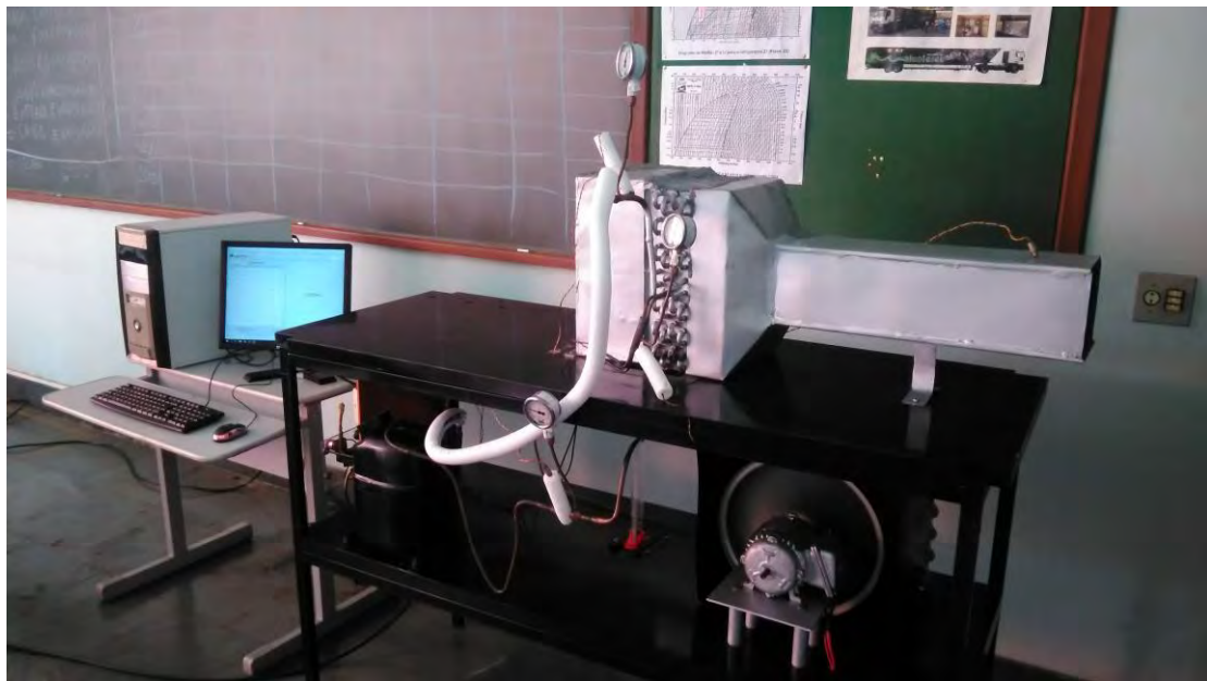
FIGURA 2 –Montagem da bancada de refrigeração.
